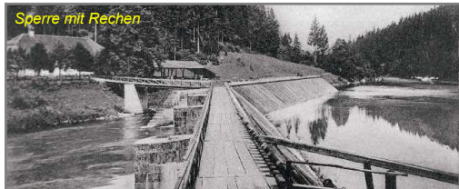
Sperre mit Rechen
